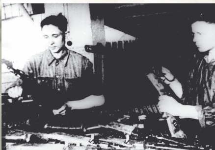
Сборка пистолетов-пулеметов системы Шпагина на заводе № 367 «Молот». Вятские Поляны Кировской области. 1943 г. Позитив. ЦГАКО. Ф. П-245. Оп. 5. Д. 103.
